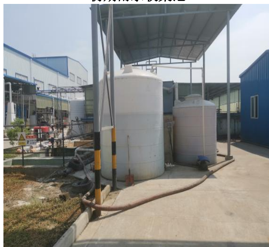
一期污水处理尾水储罐及罐车转运图片
