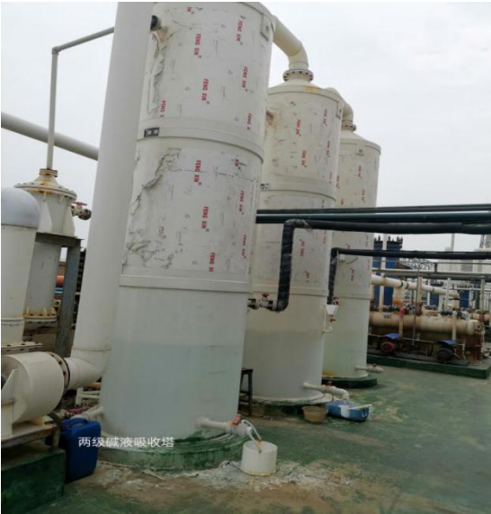
甲基磺酰氯废气处理设施（三级降膜吸收器、两级碱液喷淋塔）
