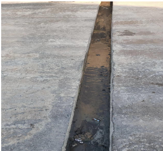
整改后-厂区地面硬化、导流沟定期清理
