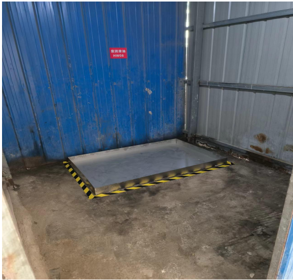
危废暂存间内部区域标识、防渗漏钢槽
