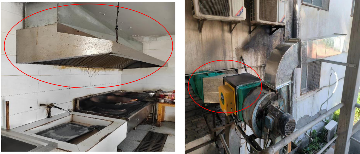
图 6-1 油烟处理设施进口不符合采样条件照片
