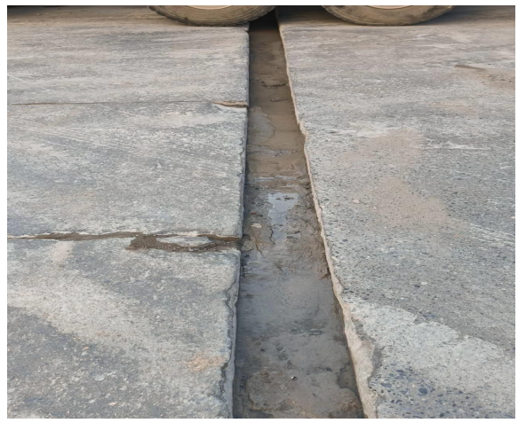
整改后-厂区地面硬化、导流沟定期清理
