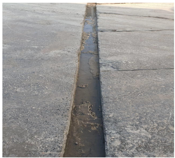
整改后-厂区地面硬化、导流沟定期清理
