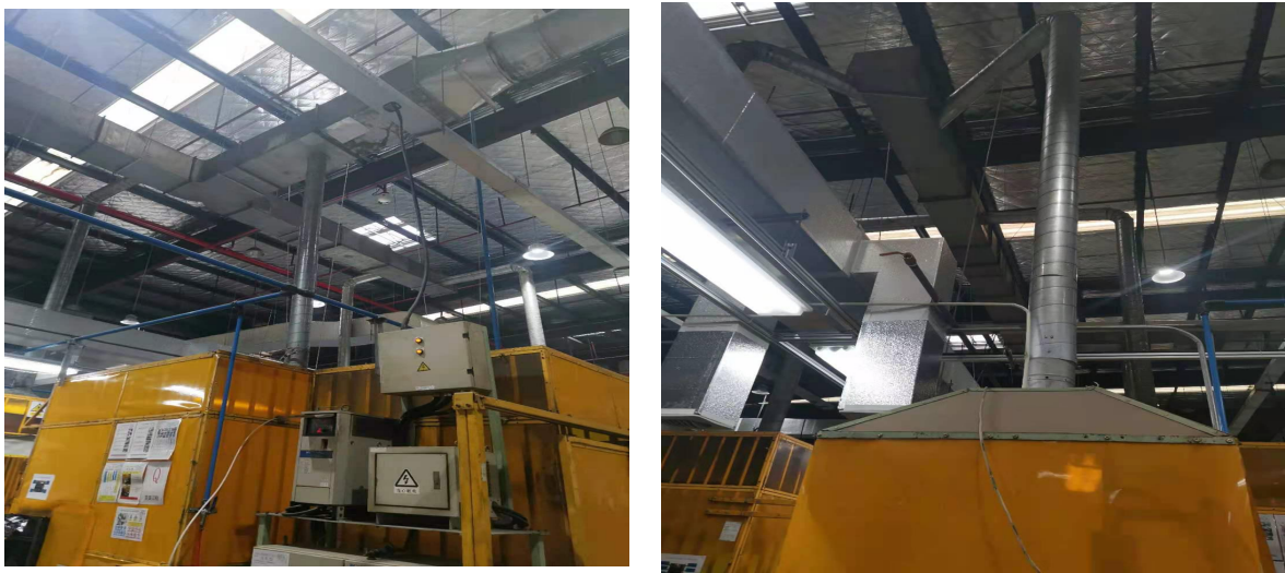
焊接工作站集气罩及管道
