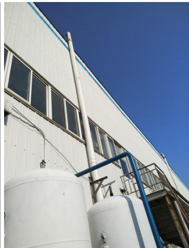
焊接废气 1#排气筒
