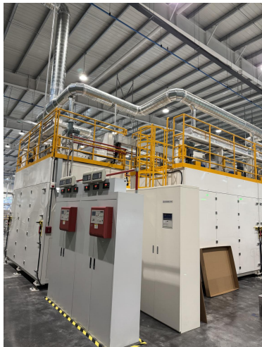
P2 定子线、DR29S 定子线滴漆固化废气收集管道
