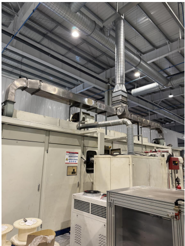
P2 定子线、DR29S 定子线滴漆固化废气收集管道
