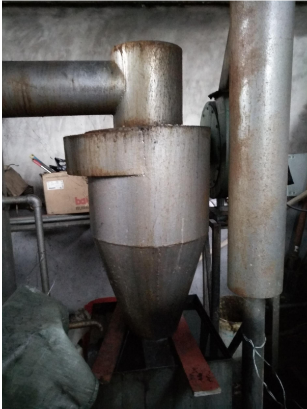
焚烧炉烟气净化设施
