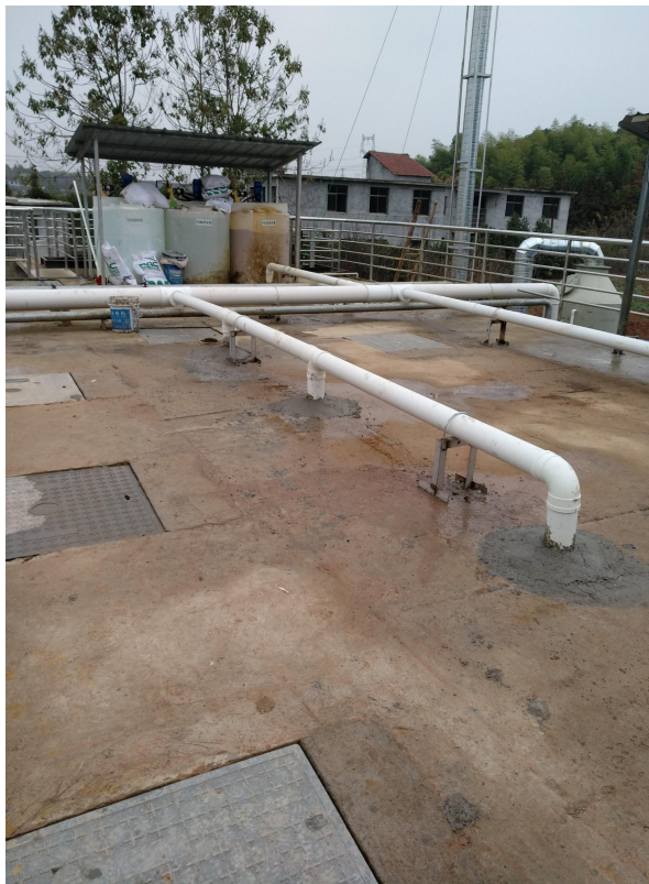
图 3-3 污水处理站恶臭加盖收集
