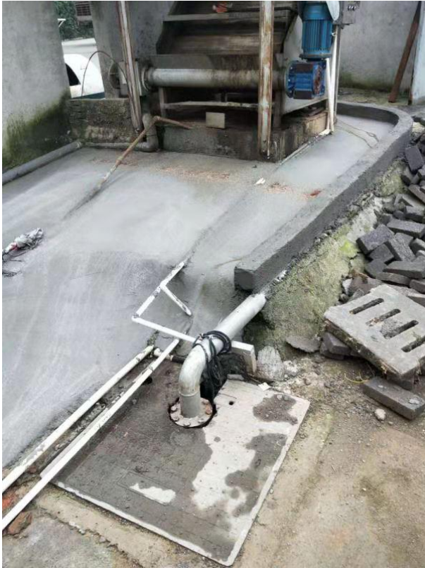
固液分离机硬化及围堰
