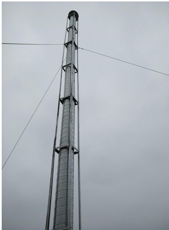
图 3-4 污水处理站臭气排气筒
