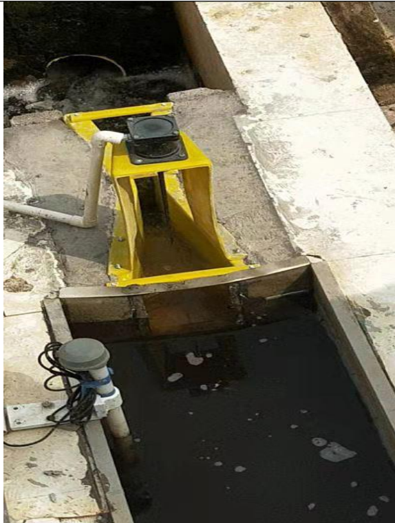
图 3-9 污水处理站废水总排口
