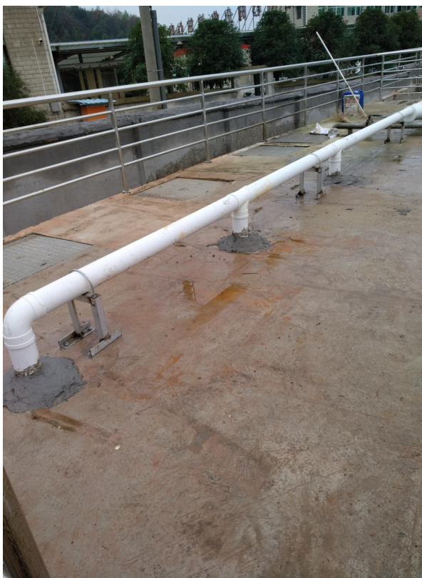
图 3-2 污水处理站恶臭加盖收集
