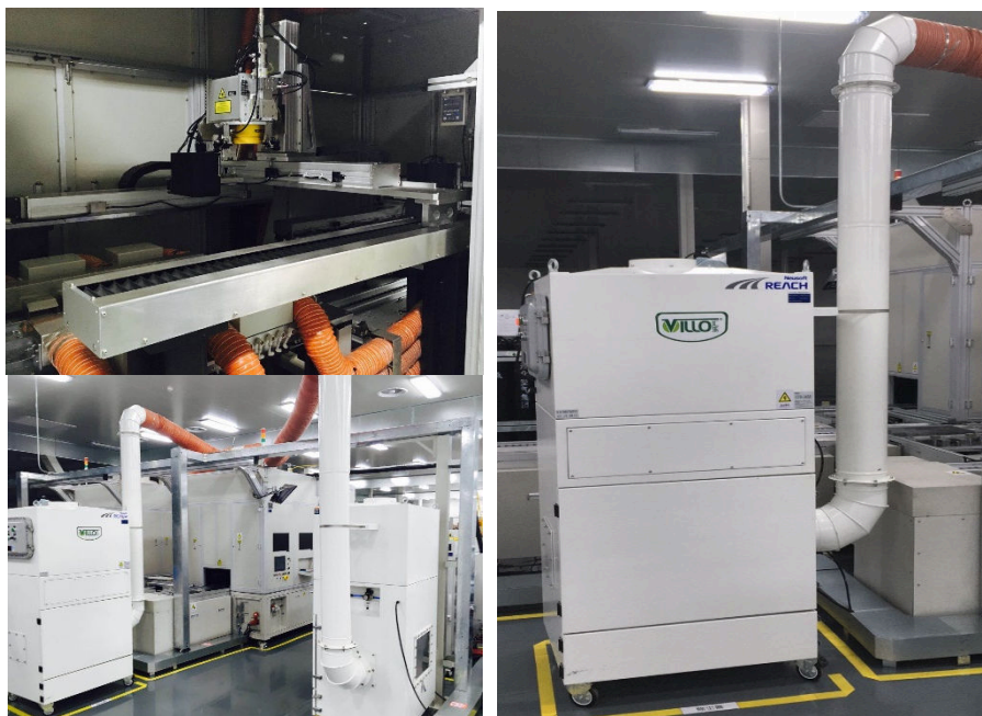
图 3-1 项目废气处理设施图片
