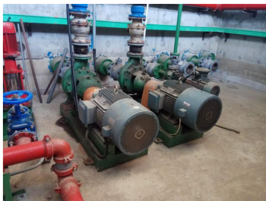
水泵房水泵隔声减振
