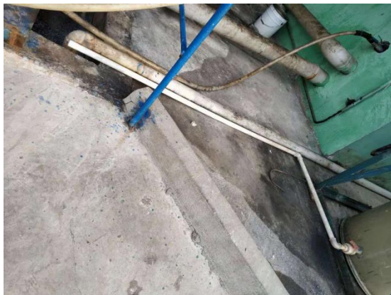
吸收塔冷凝水排水管
