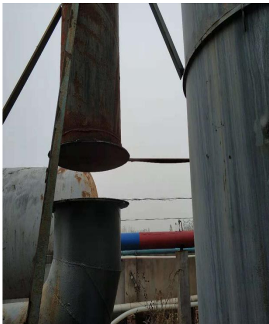
水膜除尘管道整改后
