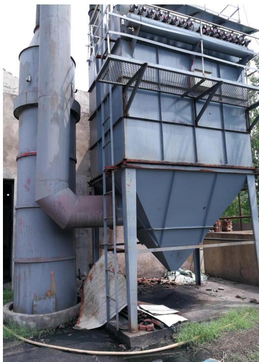
锅炉尾气收集装置
