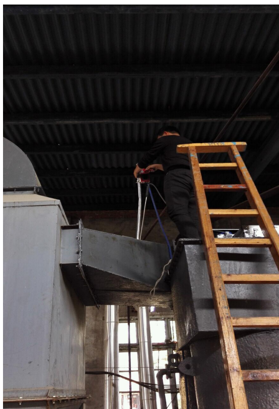
锅炉废气排气筒进口
