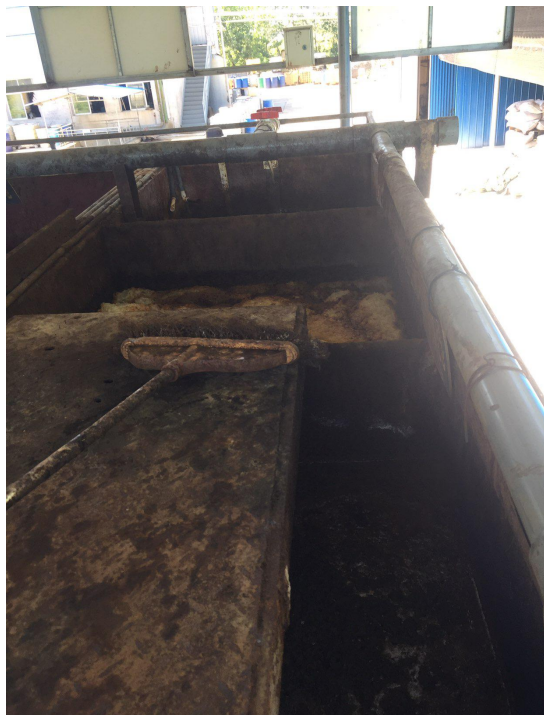
微电解塔-混凝初沉池
