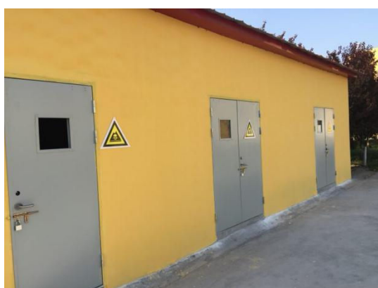
危险废物暂存间 1
