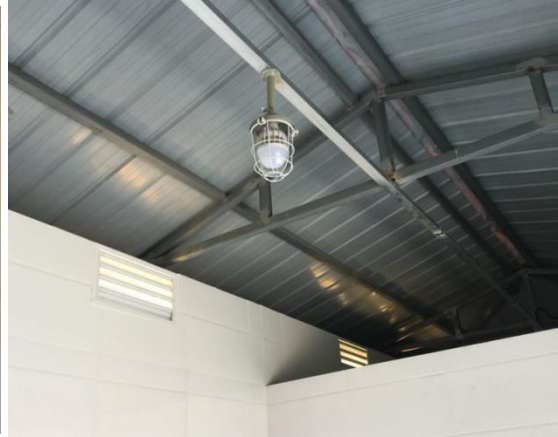
危险废物暂存间 4
