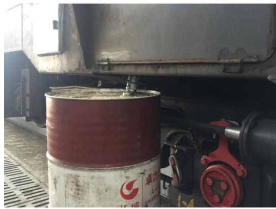
废机油收集措施 2
