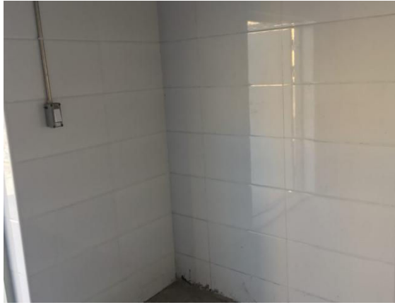
危险废物暂存间 3
