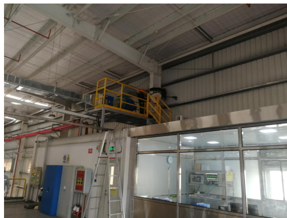
图 3-1 废气污染物处理设施
