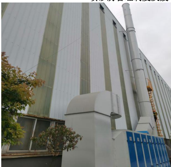
喷漆房 UV 光氧+活性炭吸附装置、气流方向指示标志
