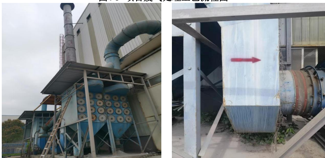
喷砂房滤芯除尘器、气流方向指示标志
