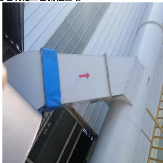
喷漆房 UV 光氧+活性炭吸附装置、气流方向指示标志
