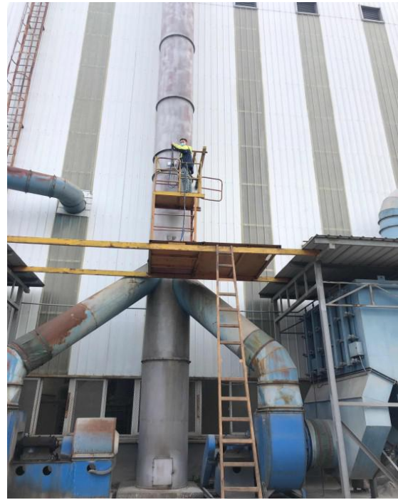
喷砂废气处理后排气筒采样口
