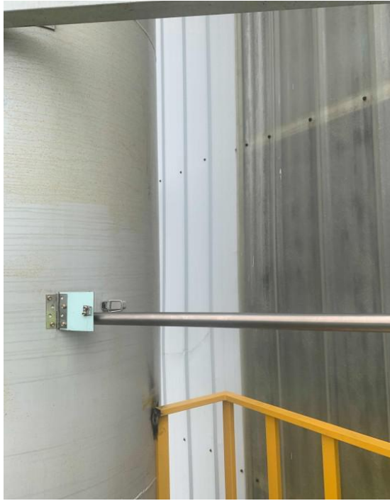
喷漆废气处理设施出口采样点
