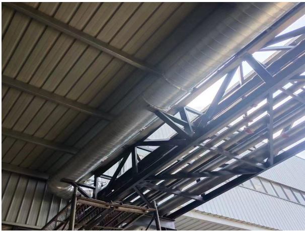
破碎废气收集管道
