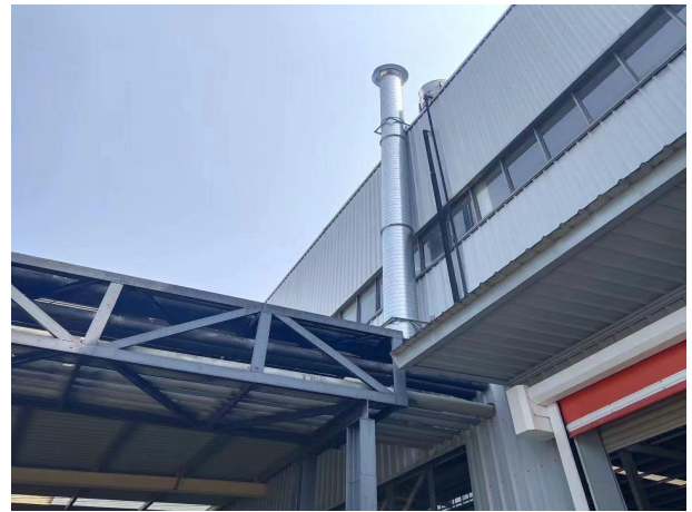
破碎废气排气筒
