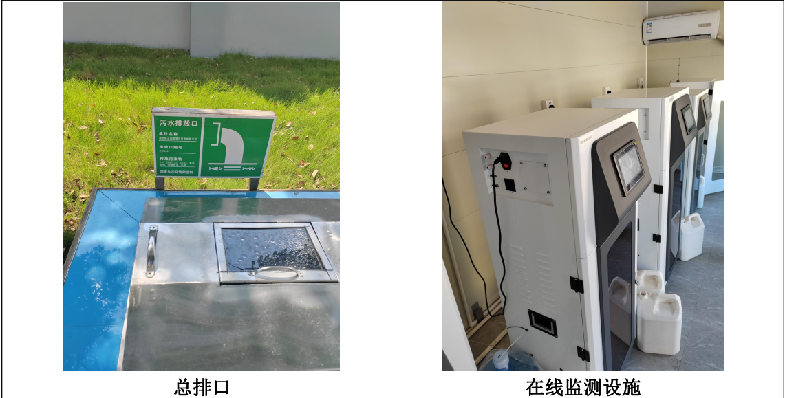
图 3-6 废水总排口及在线监测设施
