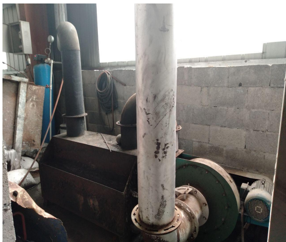
图 3-1 锅炉废气处理设施
