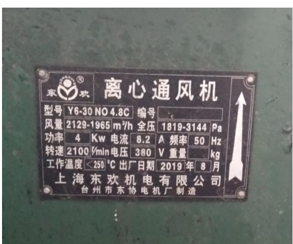
图 3-2 锅炉废气处理离心风机
