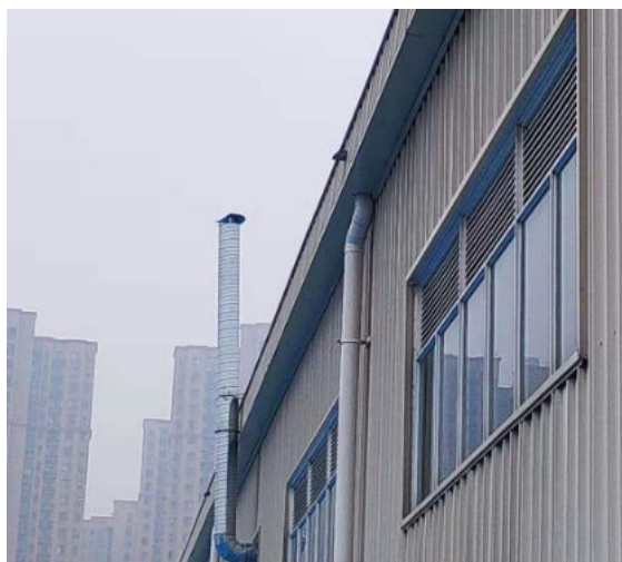
锡焊废气排气筒
